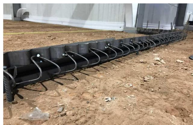
2 Bolzen auf jeder Seite am Ende des Profils (max.  $\varnothing$  16 mm) senkrecht (leicht geneigt in Richtung der Fugenlängsachse) innerhalb des Verankerungssystems in den Boden hämmern oder bohren. Ungefähr in der Mitte des Profils sind zwei zusätzliche Bolzen anzubringen (1 auf jeder Seite). 4 Bolzen sind insgesamt nötig, um die korrekte Position des Profils zu gewährleisten und notwendige Anpassungen zu ermöglichen.
