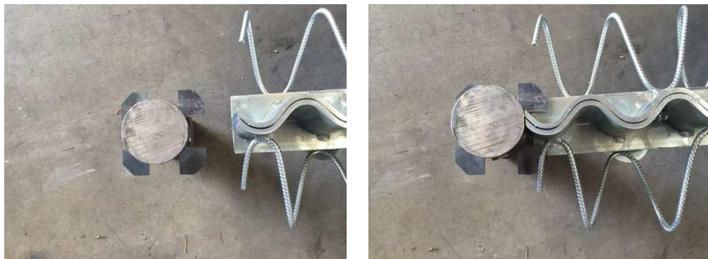
Bild 4 und 5: Platzieren des Kreuzungspunktes auf dem geschnittenen Fugenprofil.
